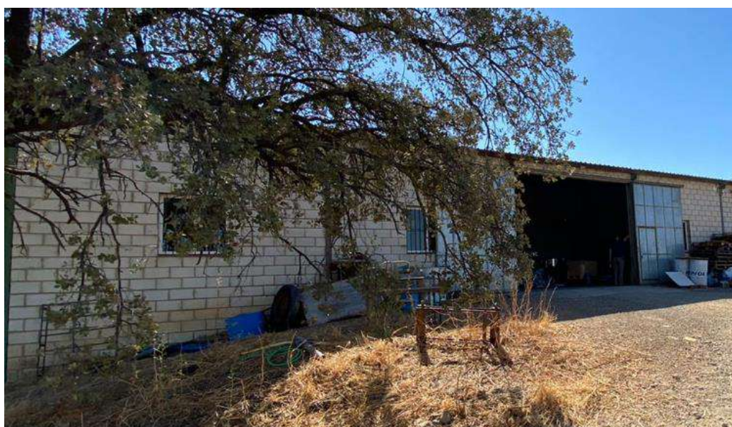
Figura 11: Lateral Oeste, almacén 1
